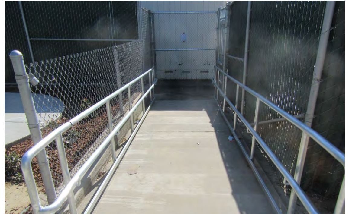
New ADA Accessible Ramp
