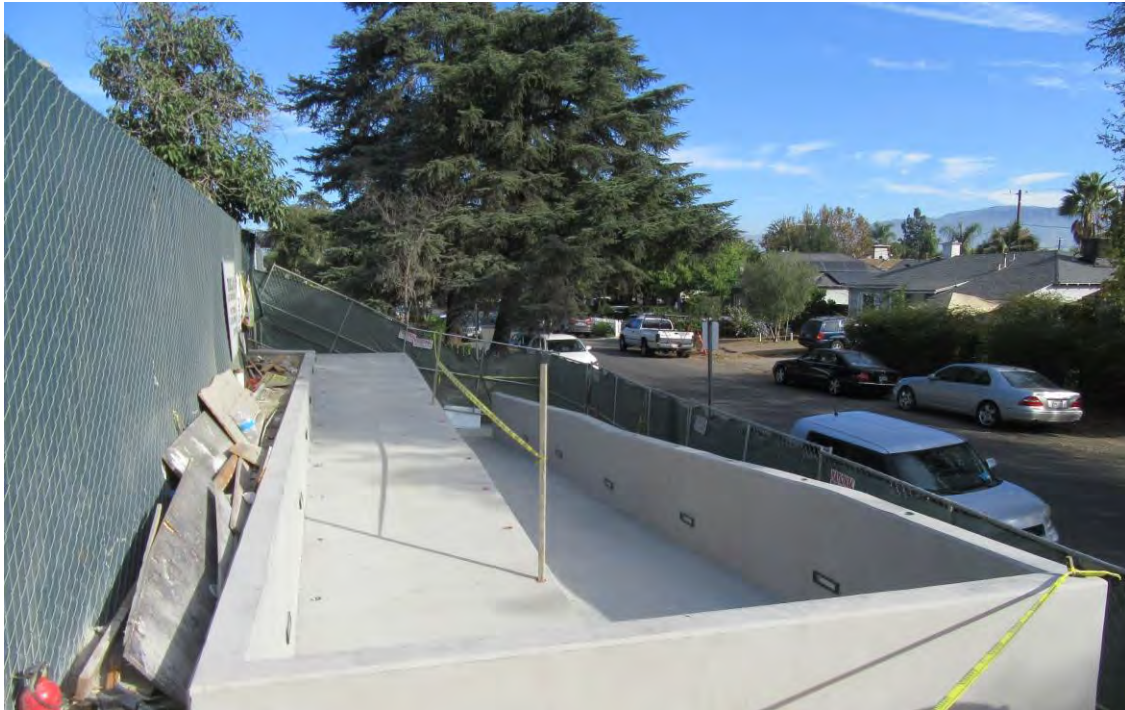
New ADA Accessible Ramp
